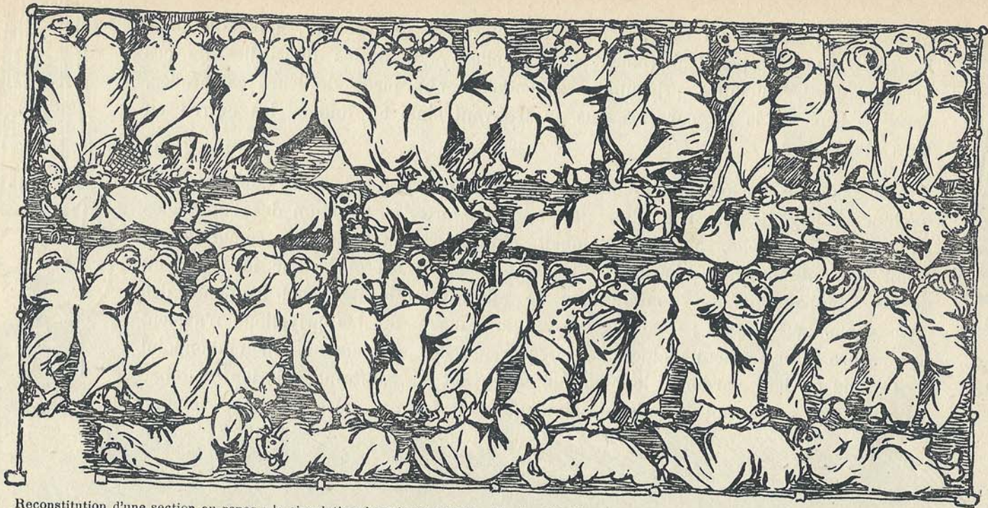
Reconstitution d'une section au repos : la circulation de nuit est difficile. De l'art d'utiliser les vides. Il est recommandé d'éviter les déplacements inutiles. L'appartement est peut-être un peu étroit, mais la Commission d'hygiène y trouverait le cube d'air suffisant.
