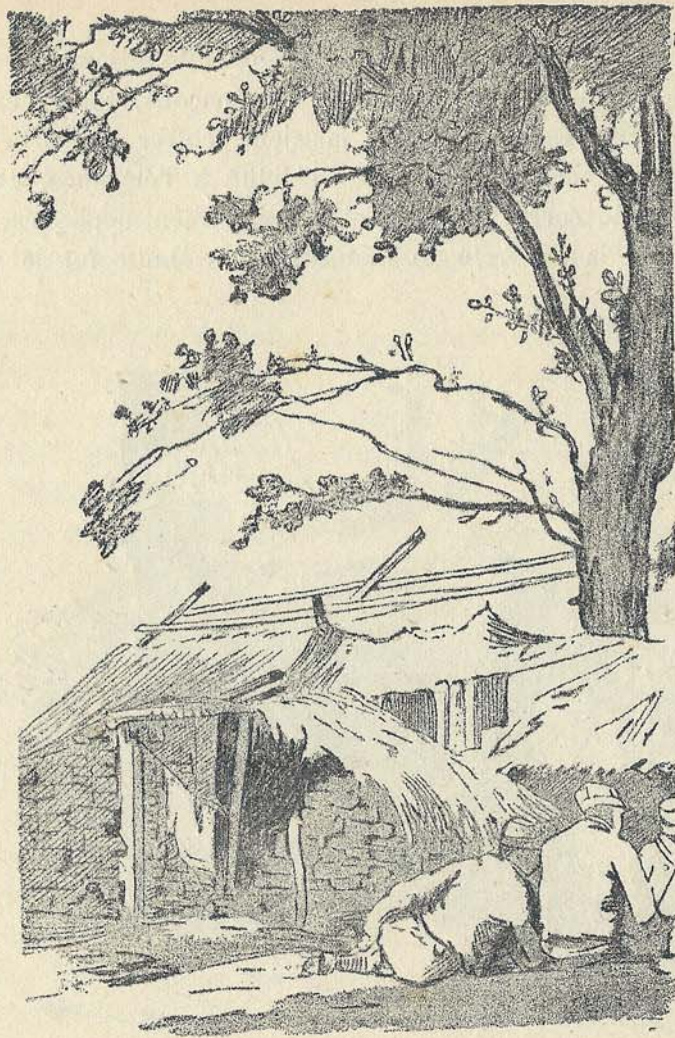
Autour d'un arbre central. — Série de petites huttes, avec poutres, rondins, morceaux de toile et fascines de branchages et de paille.
